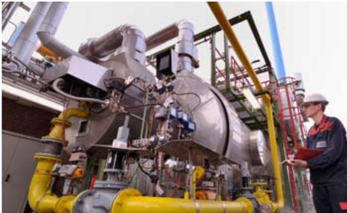
In der Reduktionsanlage wird Lachgas bei hohen Temperaturen in seine Bestandteile Sauerstoff und Stickstoff aufgespalten. Die dabei erzeugte Wärme liefert Dampf, der zur weiteren Nutzung in das Versorgungsnetz des CHEMPARKS Krefeld-Uerdingen eingespeist wird.
