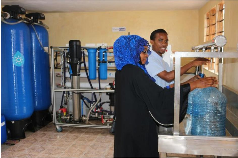
Membranelemente der Marke Lewabrane von LANXESS bereiten in dem kenianischen Dorf Burani Rohwasser mit einem hohen Salzgehalt von 4.800 ppm zu Trinkwasser auf. Die Umkehrosmose-Anlage im Wasserkiosk der Boreal Light GmbH ist solarbetrieben.
