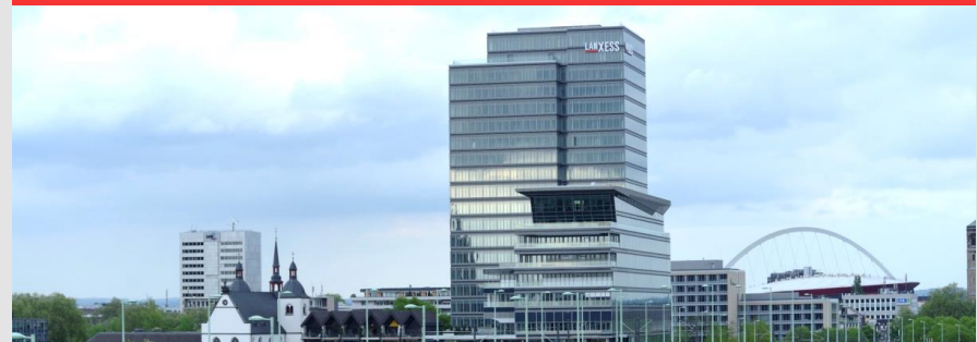
LANXESS Tower in Köln
